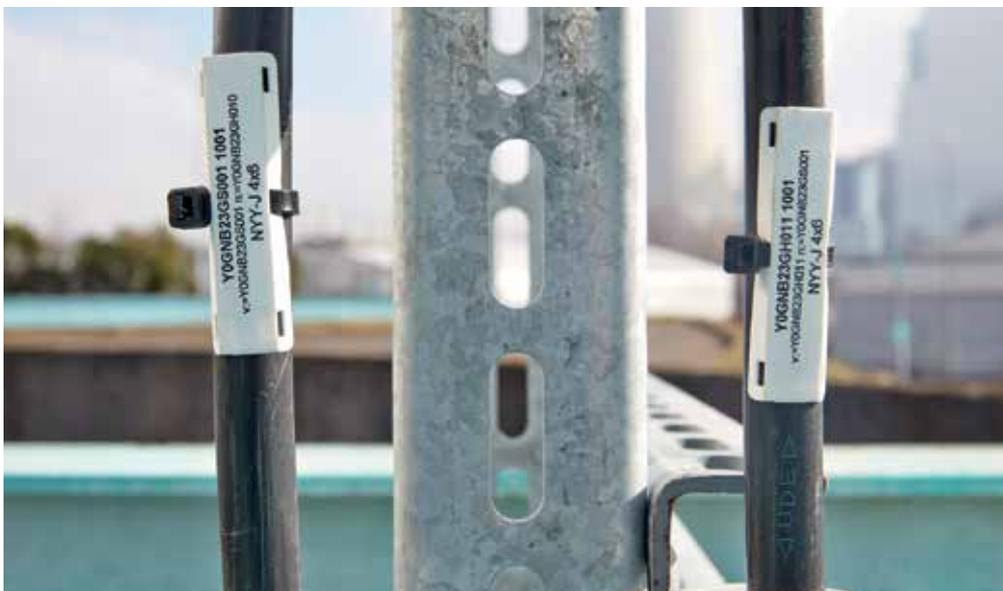
Repérage de câble conforme au système KKS ; l'étiquette reprend la clé KKS, la source, la destination, ainsi que le type de câble
