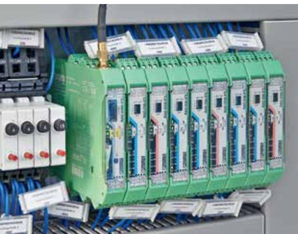
Le module maître du système Radioline peut être étendu de manière modulaire à un maximum de 32 modules d'E/S
